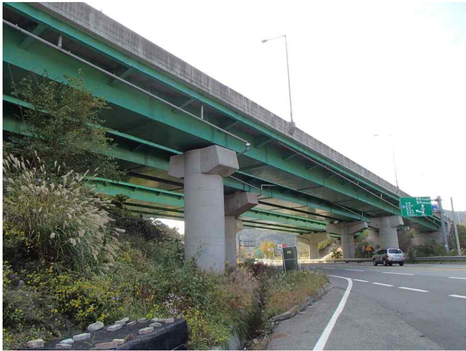
Steel Box Girder 외부 전경
