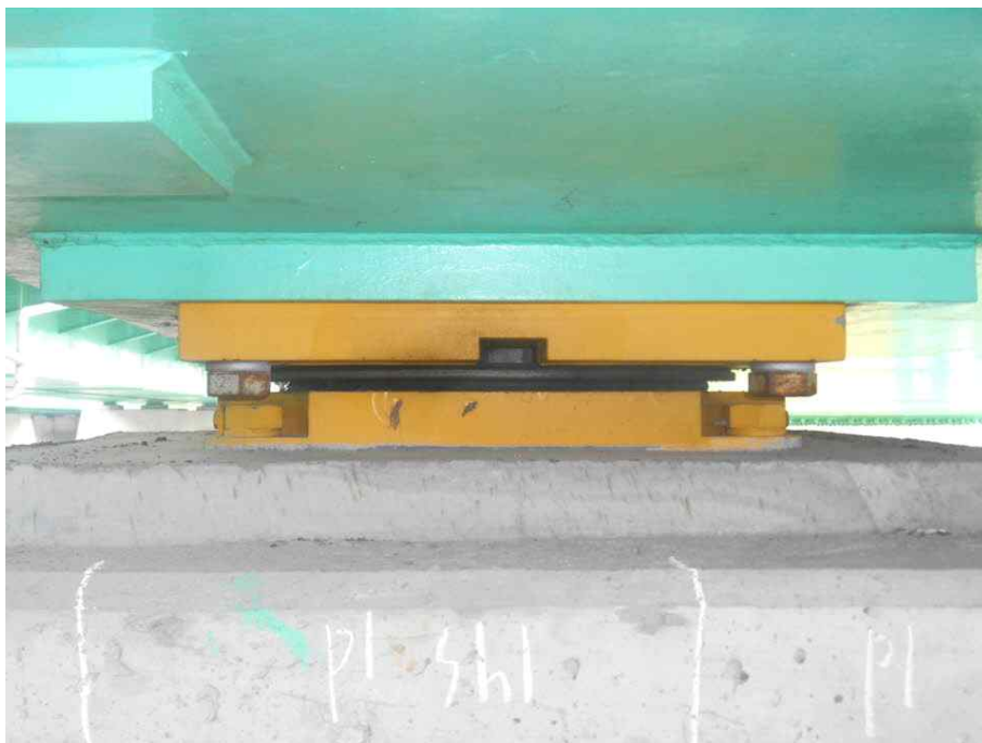
반침장치 전경 (가동단)
