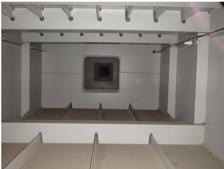
Steel Box Girder 내부 전경
